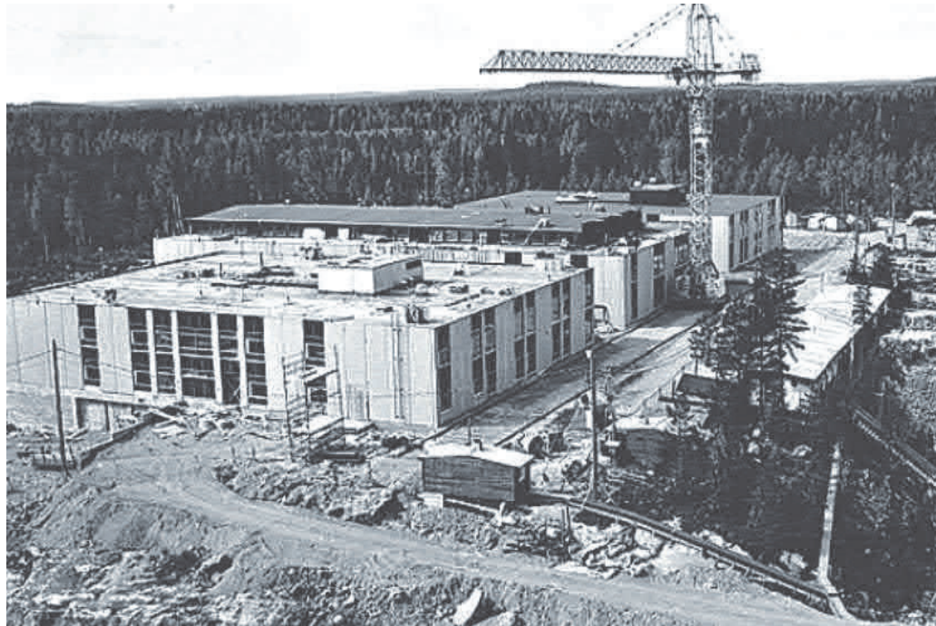
Kannen kuva: Pohjois-Hervannan koulun välituntipihaa marraskuussa 2019. Mikko Suominen. Tämä sivu: Uutta koulua rakennetaan vuonna 1974.
