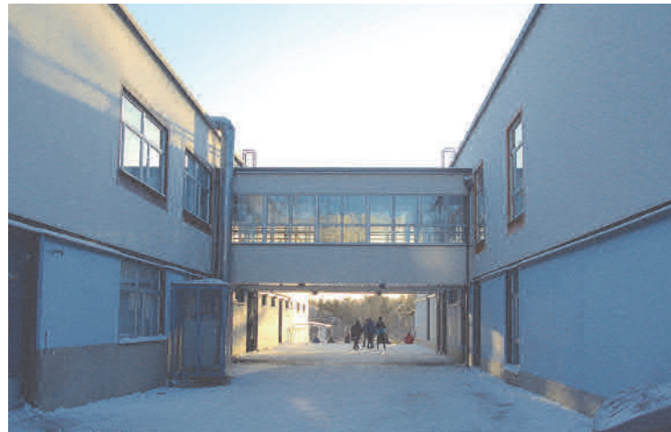
Rakennuksen julkisivut on eristerapattu sileiksi ja väritys muutettu.
